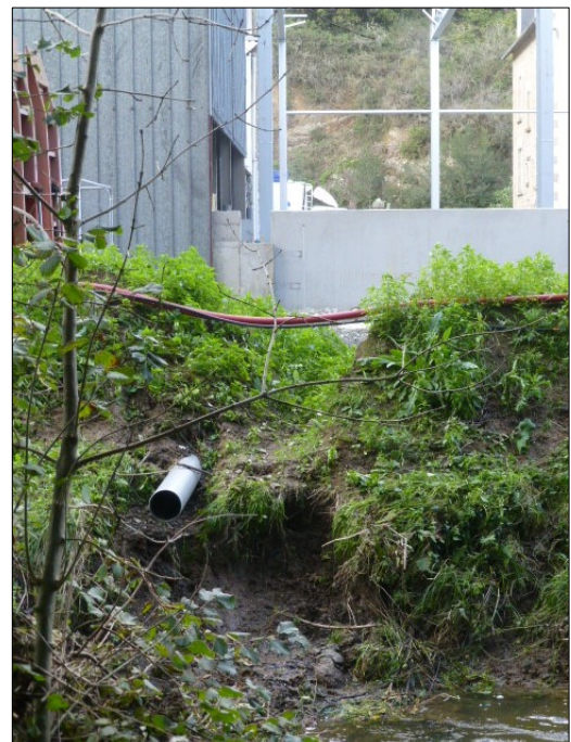
Érosion du remblai
