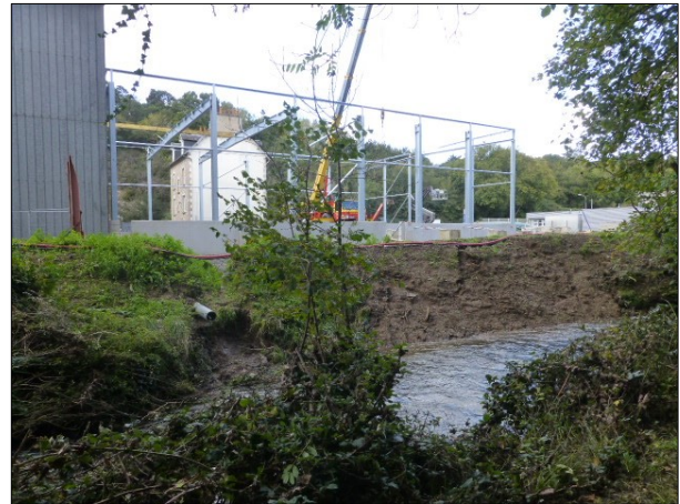
Érosion du remblai
